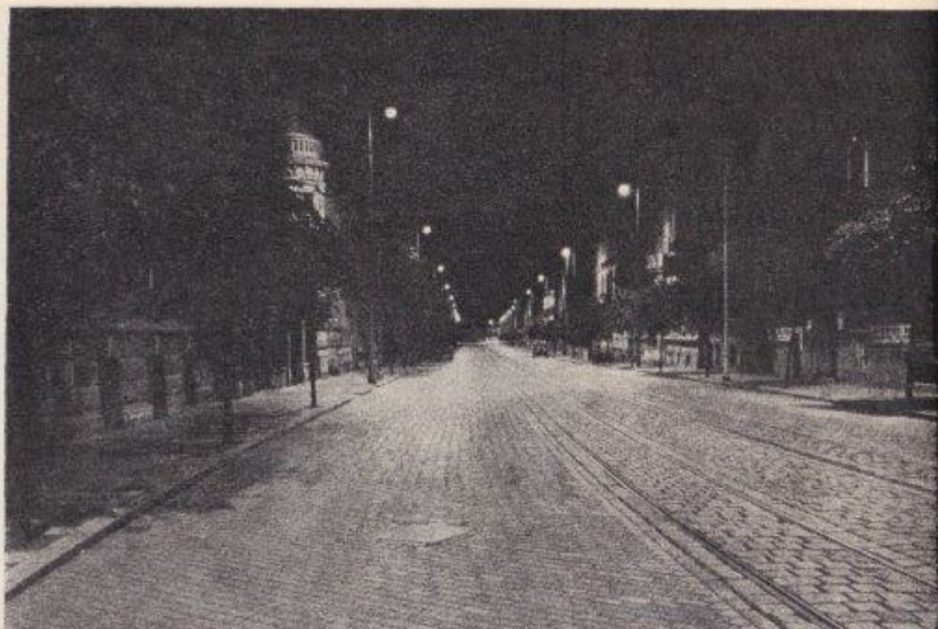
VZORNÉ OSVĚTLENÍ ULICE SMÍŠENÝM SVĚTLEM RTUŤOVÝCH LAMP „PHILORA“ A ŽÁROVEK (BRATISLAVA)
